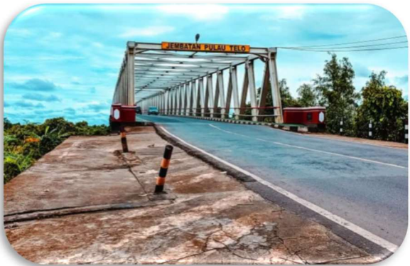
Jembatan Pulau Telo
